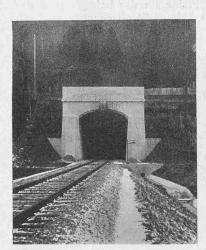
Abb. 19. Eisenbeton-Portal des Schlossberg-Tunnels in Tübingen.
