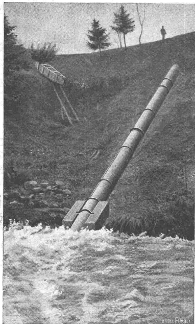
Automatischer Saugüberfall in Gibswil (Kanton Zürich).
