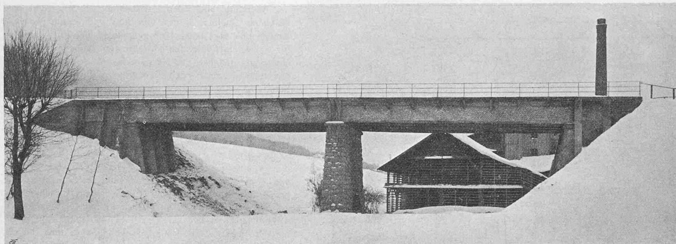
Abb. 4. Ansicht der Suze-Brücke in St. Imier von Nordosten.
