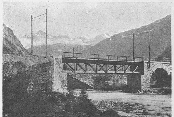
Abb. 6. Kontaktleitung auf der Drance-Brücke.
