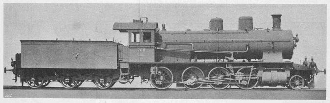
Abb. 7. Gleichstrom-Dampflokomotive Serie C4/5 der S. B. B., gebaut von der Schweiz. Lokomotivfabrik Winterthur.
