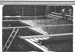
bestehend aus einzelnen, fabrikmässig hergestellten Zement-Hohlbalken, mit armierten Seitenwandungen für beliebige Spannweiten bis 6,50 m
