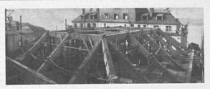
Abb. 5. Dachbinderkonstruktion über Magazin II.
