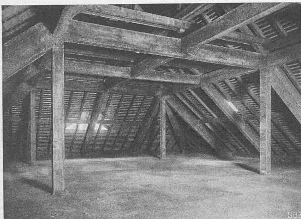
Abb. 6. Innenansicht der Dachkonstruktion, Magazin II.
