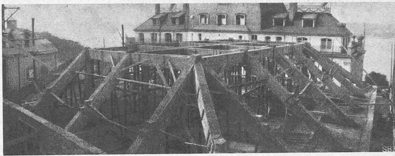
Abb. 5. Dachbinderkonstruktion über Magazin II.
