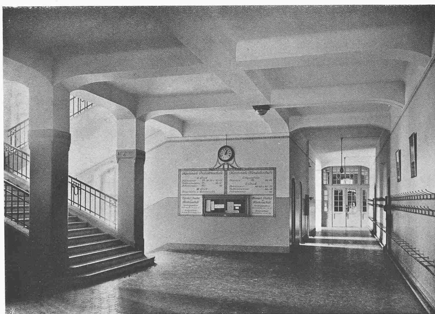
Treppenhaus und Vorplatz im Erdgeschoss des Südflügels
