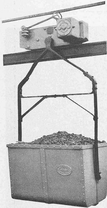
Abb. 1. Elektrohängebahn auf Kopfschiene.
