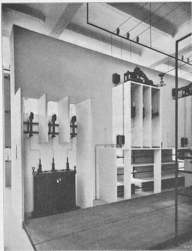
Abb. 48. Blick auf Zellenreihe II, bzw. Spannungswandler (30) und Transformatorenschalter für 25 000 Volt (26).
