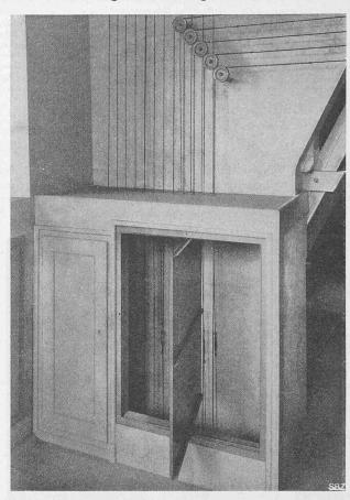
Abb. 24. Frischluftschacht nach der untern Heizkammer.
