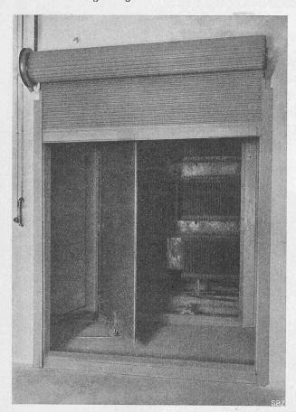
Abb. 25. Frischluft-Eintritt in die obere Heizkammer.
