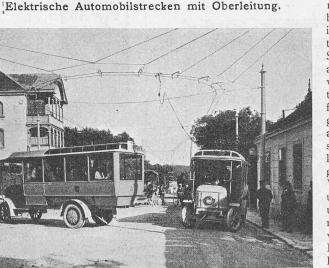
Abb. 7. Wendeschleife der Kontaktleitung am Streckenende.
