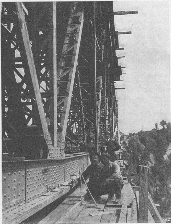
Abb. 59. Messung der Durchbiegung in Brückenmitte.
