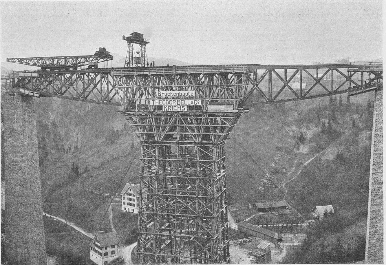
Abb. 56. Oberer Teil des Gerüstturms, Montage nahezu vollendet, Aufziehen der Auflagerquader mittels des Hubkrans im April 1910.
