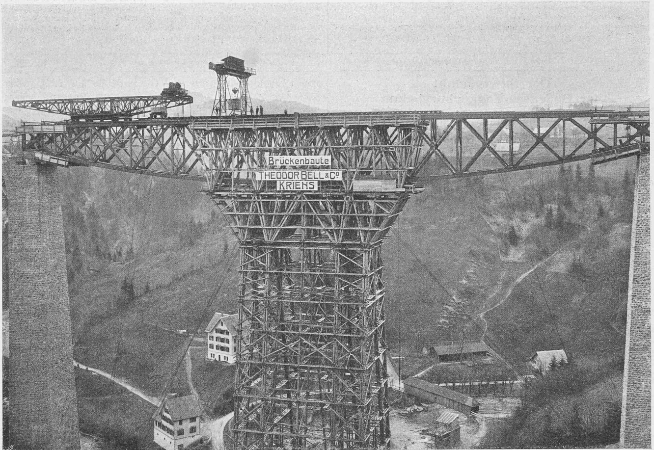
Abb. 56. Oberer Teil des Gerüstturms, Montage nahezu vollendet, Aufziehen der 7. Auflagerquader mittels des Hubkrans im April 1910.
