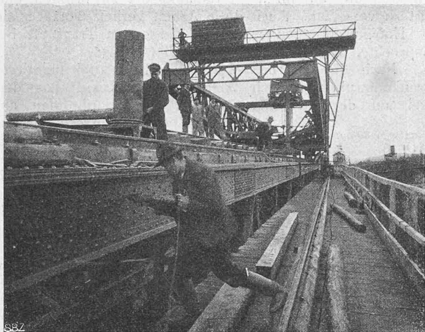
Abb. 55. Pressluft-Nietung am Obergurt (29. XII. 1909).
