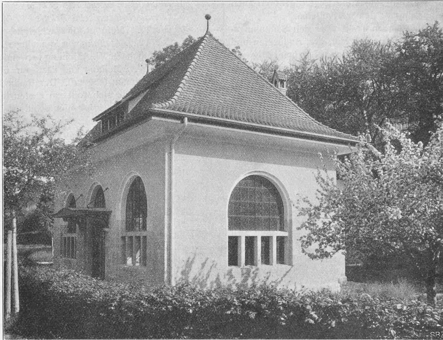
Abb. 4. Ansicht des Pumpwerks Rheinhalde. — Architekt C. Werner, Schaffhausen.
