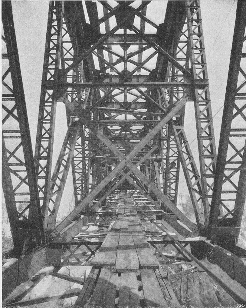
Abb. 35. Blick durchs Brückeninnere von Knoten 3 gegen festes Auflager (1 IV. 1910).
