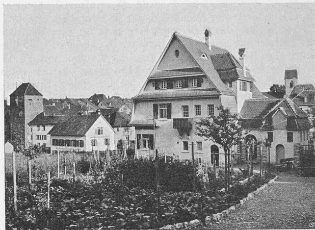
Abb. 9. Försterhaus Rothpletz von Nordwesten (Rückseite).
