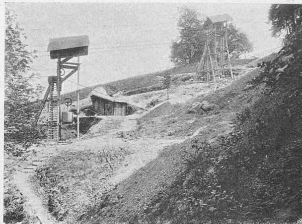
Abb. 13. Spannböcke der beiden Kabelbahnen.
