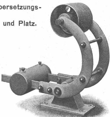
Wir liefern die Lenix-Spannrollen-Apparate in Normal-Ausführungen, an jedem Elektromotor, auch an bestehenden, anwendbar; für vertikale, schräge und horizontale Elementtriebe.
