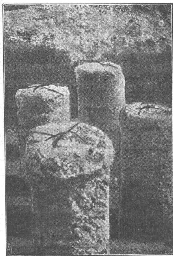
Simplexbetonpfähle
