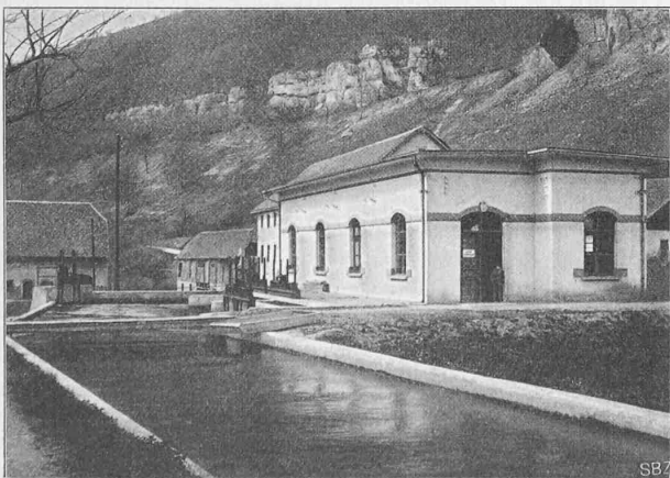
Abb. 5. Oberwasserkanal und Maschinenhaus.
