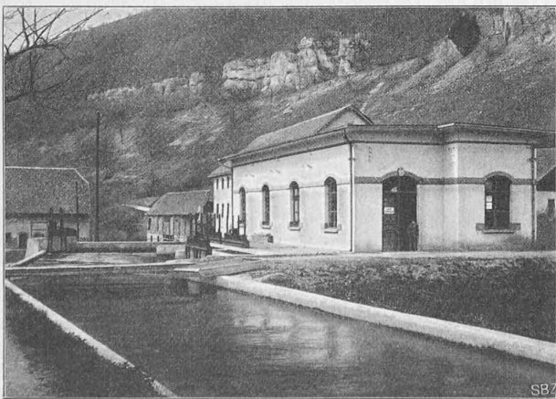
Abb. 5. Oberwasserkanal und Maschinenhaus.
