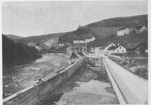
Abb. 26. Oberwasserkanal und Maschinenhaus. (30. März 1909.)
