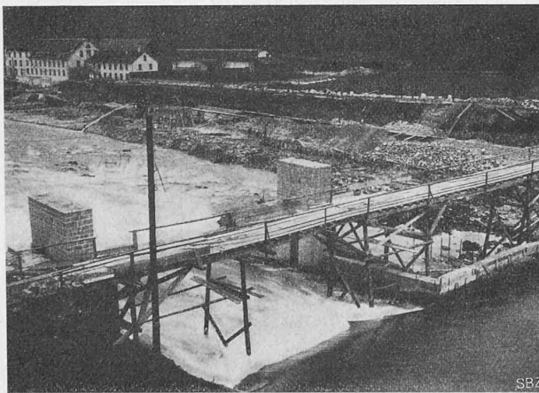
Abb. 13. Wehrschwelle I vollendet bei Mittelwasser. (15. November 1907.)
