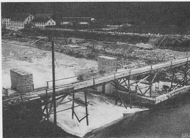
Abb. 13. Wehrschwelle I vollendet bei Mittelwasser. (15. November 1907.)
