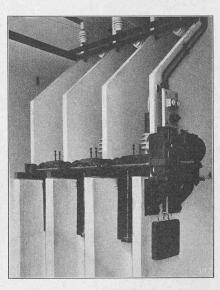
Abb. 103. Einpolige Oelschalter für 27000 V. mit servomotorischem Antrieb.
