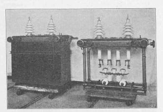
Abb. 104. Einpoliger Oelschalter für 48 000 Volt, mit sechs Unterbrechungen.
