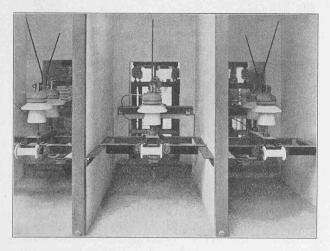
Abb. 101. Ausschaltbare Hörner-Blitzschutzapparate, 27000 Volt.
