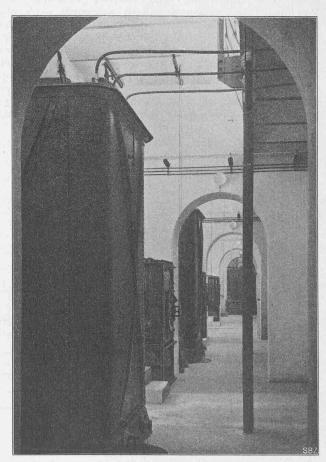
Abb. 96. Transformatorenraum im Untergeschoss.
