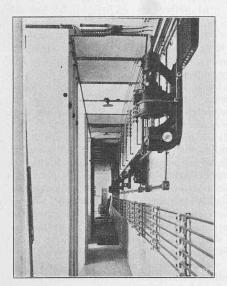
Abb. 107. Regulierwellen-Antrieb im Schalterraum.
