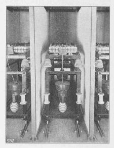
Abb. 102. Ausschaltbare Wurz-Blitzschutzapparate, 27000 Volt.
