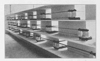
Abb. 100. Sammelschiene für 8000 Volt.
