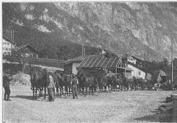
Abb. 93. Zufuhr eines Stator-Oberteils zur Zentrale.
