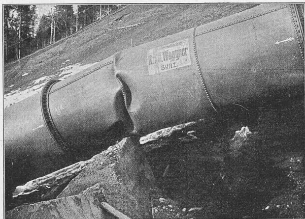
Abb. 28. Untere Knickung des Rohrstranges links.
