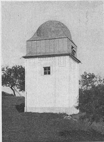
Abb. 7. Transformatorenhäuschen.
