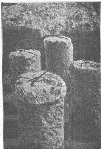
Simplexbetonpfähle
