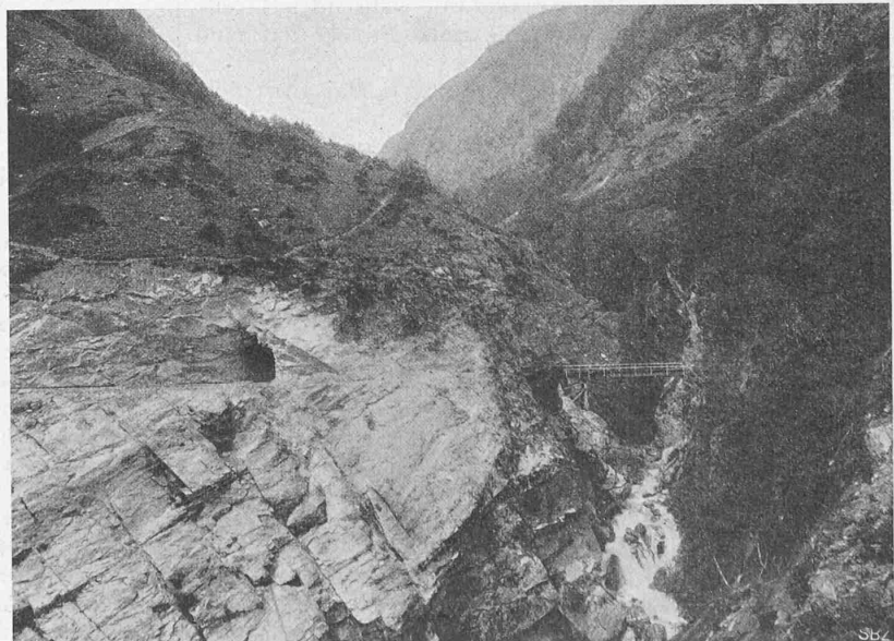
Abb. 22 Dienstbahnbrücke über den Baldschiederbach.
