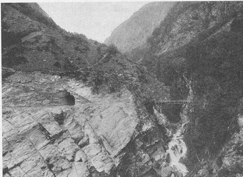
Abb. 22 Dienstbahnbrücke über den Baldschiederbach.
