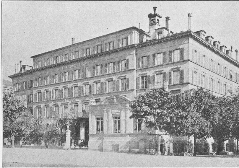
Abb. 2. Fassade an der Bundesstrasse vor dem Umbau.
