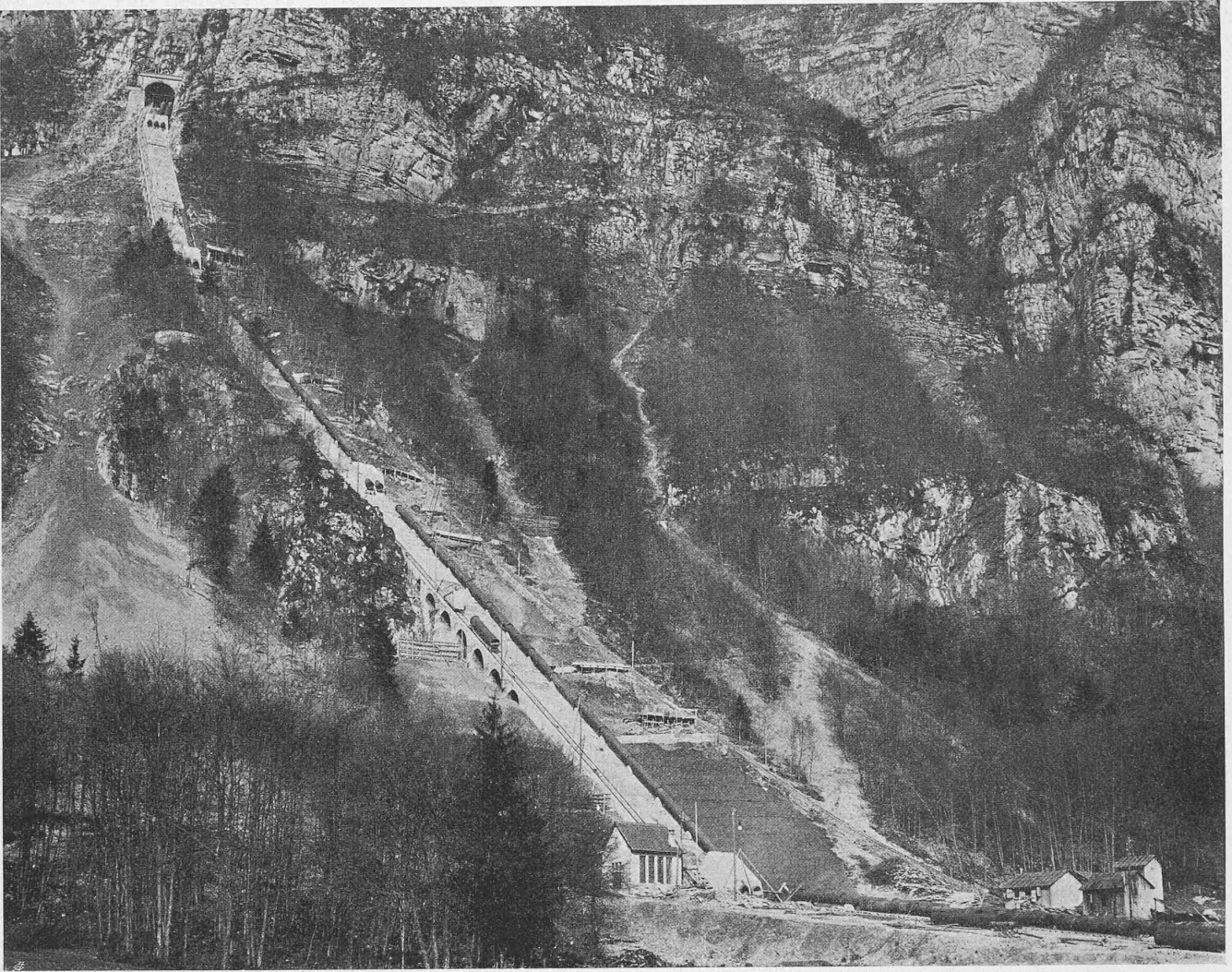
Abb. 70. Blick auf die Steilpartie der Druckleitung mit beiden Seilbahnen, während der Rohrmontage (1. Mai 1908).
