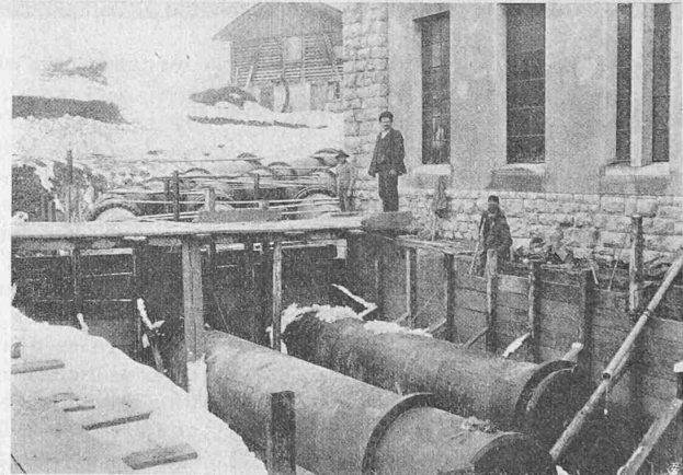
Abb. 65 und 66. Verankerungsklotz VI an der obren Maschinenhausecke, vor Einbetonierung der Druckleitungen (27. Febr. 1908).
