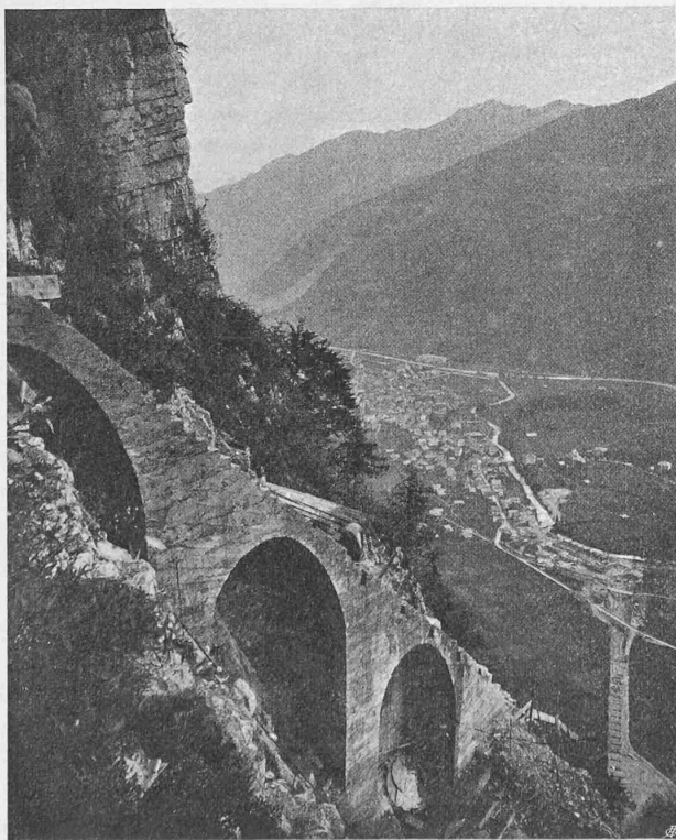
Abb. 62. Oberste Partie des Druckleitungs-Unterbaues (Juni 1907).
