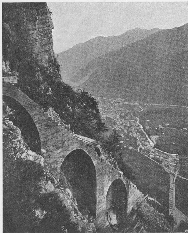
Abb. 62. Oberste Partie des Druckleitungs-Unterbaues (Juni 1907).
