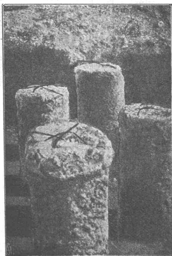
Simplexbetonpfähle
