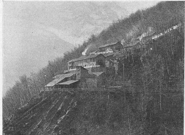
Abb. 55. Bauplatz Unterwädli bei Stollenfenster I.
