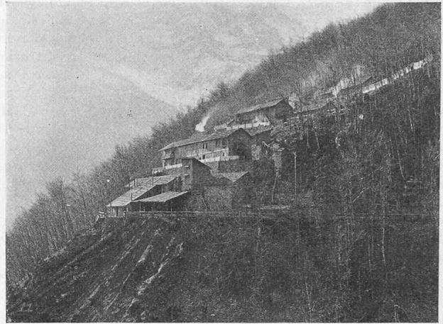
Abb. 55. Bauplatz Unterwäldli bei Stollenfenster I.
