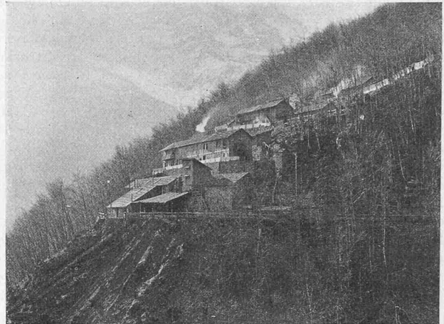
Abb. 55. Bauplatz Unterwäldli bei Stollenfenster I.
