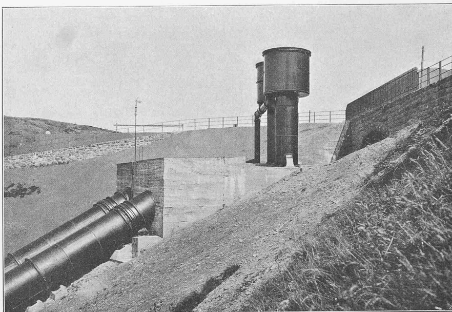
Abb. 26. Fixpunkt I mit den Standrohren der beiden Rohrstränge.
