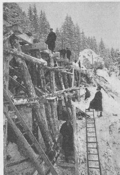
Abb. 4. Mittelloffnungen der Notbrücke.
