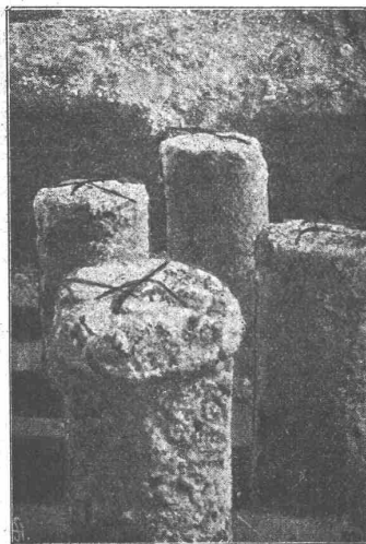
Simplexbetonpfähle
