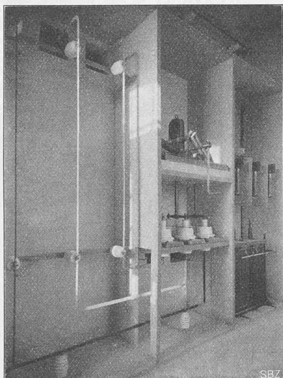
Abb. 21. Hauptschalter d. ankommenden Linie.
