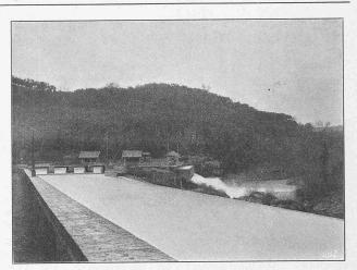
Abb. 2. Einlauf in das Klärbecken; Spülschleusen.
