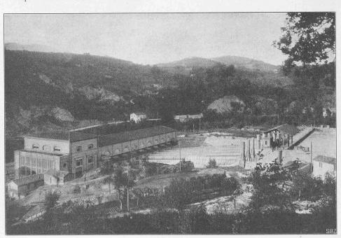
Abb. 3. Neue Zentrale Cervara mit Wasserschloss und Druckleitungen.
