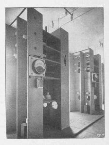
Abb. 23. Einzelschaltzelle f. d. Transformatoren.
