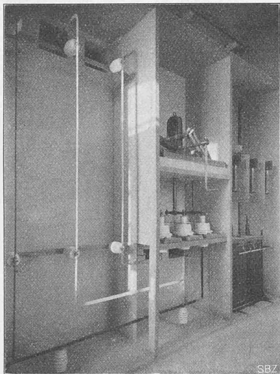
Abb. 21. Hauptschalter d. ankommenden Linie.
