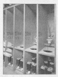
Abb. 15. Funkenstrecken und Wasserwiderstände.
