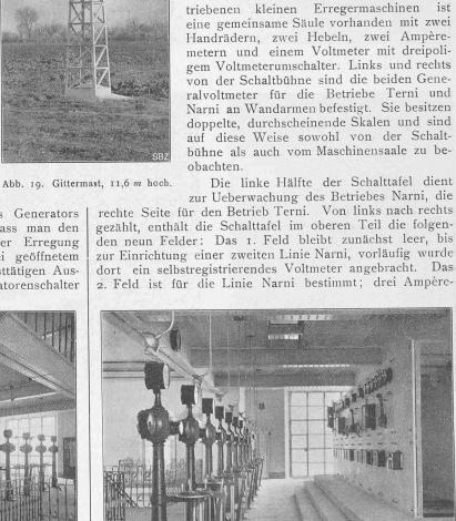
Abb. 18. Schaltsäulen mit den Handhebeln.
