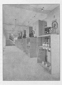
Abb. 13. Transformatorenschalter für 27000 V.
