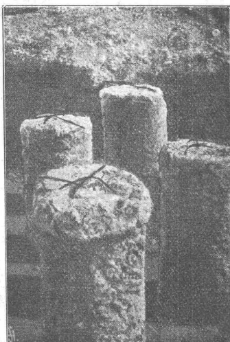
Simplexbetonpfähle
