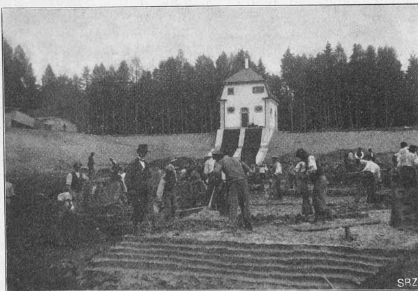
Abb. 23. Abdichtung der Weihersohle (September 1909).
