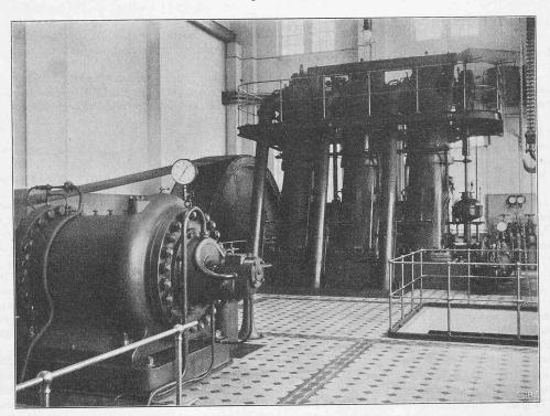
Abb. 2. Innenansicht des Motorengehäudes mit Dieselmotor und Hochdruckzentrifugalpumpe von Gebr. Sulzer in Winterthur.
