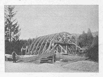
Abb. 20. Lehrgerüst einer Seitenöffnung.
