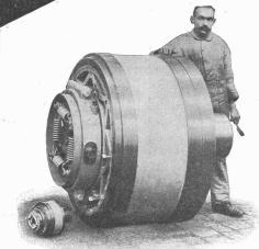
Benn Kupplung Nr. 12 für 600 P.S. gellefert in eine Zementfabrik. Reibungsflächen Eisen auf Eisen Keine Holzbacken Reibungsflächen laufen in Oel Vollständig geschlossen Reibungsflächen scheibenförmig Keine vorstehenden Teile
