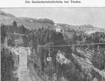
Abb. 6. Betonbeförderung in der Brückenachse.
