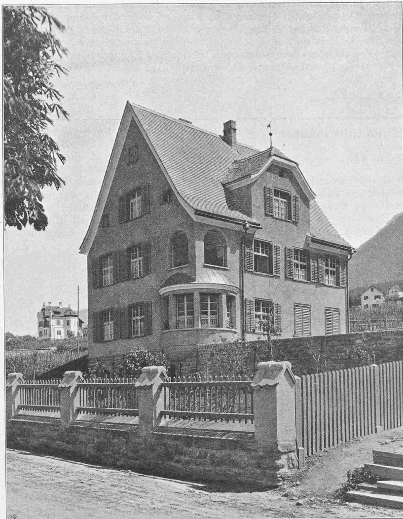
Abb. 4. Ansicht von Südwesten.
