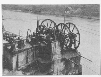
Abb. 5. Richtungsänderung und mehrfache Kraftabgabe auf Pfeiler IV.
