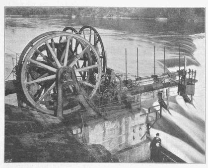
Abb. 3. Winkeltrieb auf Pfeiler I der alten Schaffhauser Seiltransmission.
