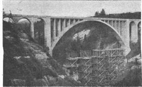
Gmündertobelbrücke; grösster Bogen in armiertem Beton von 79 m Spannweite. Vollendet 1908.
