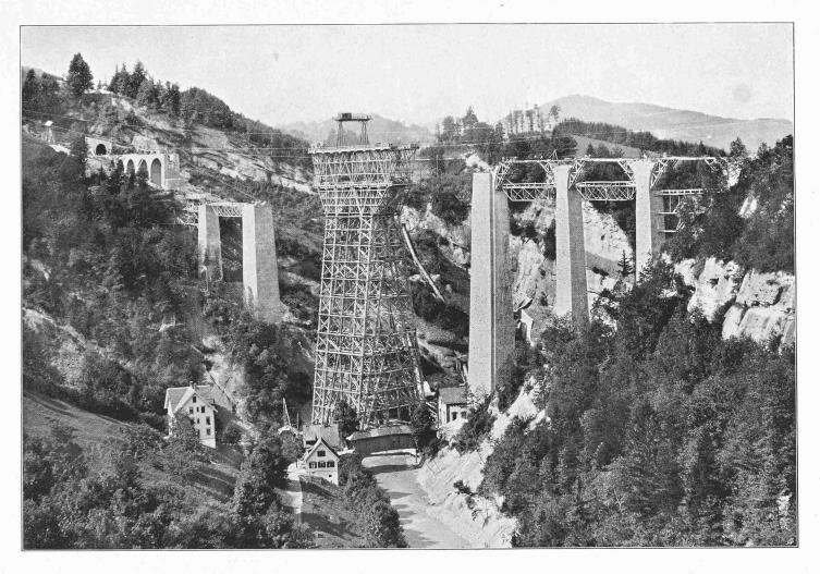
MONTIERUNGSGERÜST DES EISERNEN MITTELTRÄGERS DER SITTERBRÜCKE FÜR DIE B.-T.
