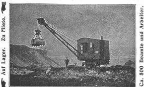
Heissdampf - Vierseil - Greifbagger Heissdampf-Kräne Menck's Patent - Einketten - Selbstgreifer
