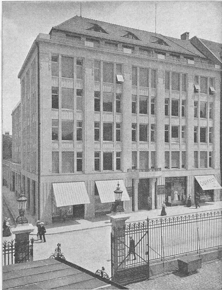
Abb. 6. Fassade an der Kornhausstrasse.
